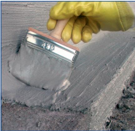
**1** Zwischenabdichtung des Wand-/Sohle-Anschlussbereiches
