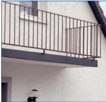
**2** Carbonatisierungsschutz von bewehrten Betonbauteilen wie z.B. Kragplatten o.A.
