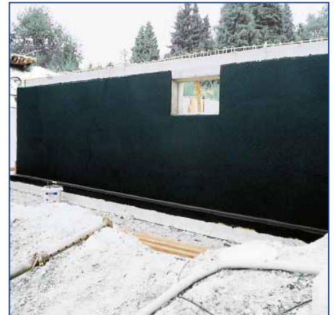
6 Fertig und sicher abgedichtet mit IMBERAL® 2K Winter 26B .
