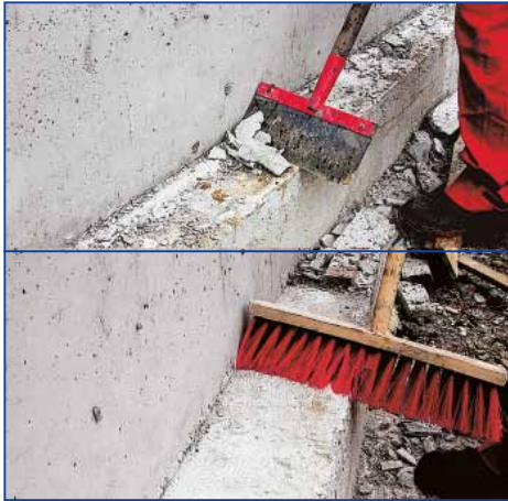
1 Untergrund gründlich reinigen und Sinterschichten entfernen.
