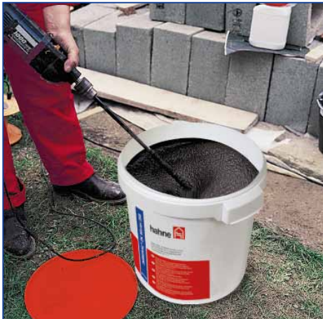
4 IMBERAL® 2K Winter 26B durch langsam laufendes Rührwerkzeug mit Rührpaddel anrühren.
