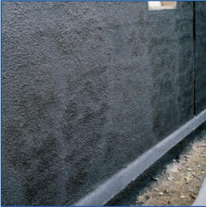
1 Durchgetrocknete Bitumen-Dickbeschichtung, z. B. **IMBERAL® 2K 20B**, **IMBERAL® S100 90B** oder auch jede andere Bitumen-Dickbeschichtung (KMB).
