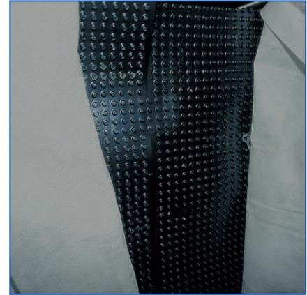
3 Zur Überlappung wird immer die Anschlussbahn unter den Vliesrand geschoben.
