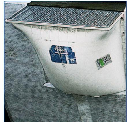
6 Bei Kabel-, Rohrdurchführungen oder Kellerschächten mit dem Cuttermesser einfach passend ausschneiden.
