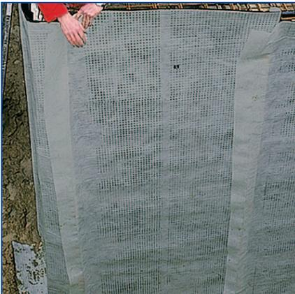
4 Bei Außenkanten die Vlieskaschierung einschneiden. Bei Innenecken braucht **IMBERAL® Multidrain 89V** nur vorgeknickt zu werden.
