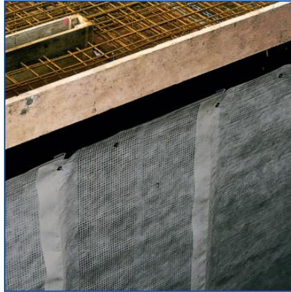
2 **IMBERAL® Multidrain 89V** von der Rolle auf genaues Maß zuschneiden und mechanisch mit Tellerdübel o. Ä. befestigen. Mittels Kappleiste o. Ä. verwasen, um das Eindringen von Schmutz zu verhindern.
